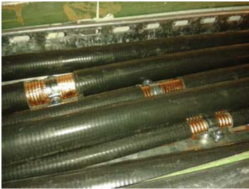
Mise à la masse intermédiaire des écrans des câbles venant du poste 225kV
