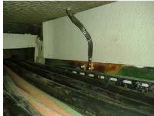
Mise à la masse intermédiaire des écrans des câbles venant du poste 225kV
